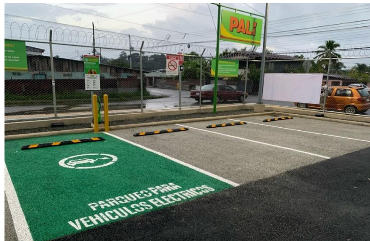
Parqueo en concreto permeable, Drenacreto Pali Limoncito para Rae Ingenieros S.A
