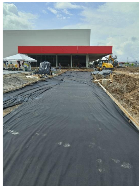
Parqueos en Concreto Permeable, Drenacreto Pequeño Mundo Alajuelita
