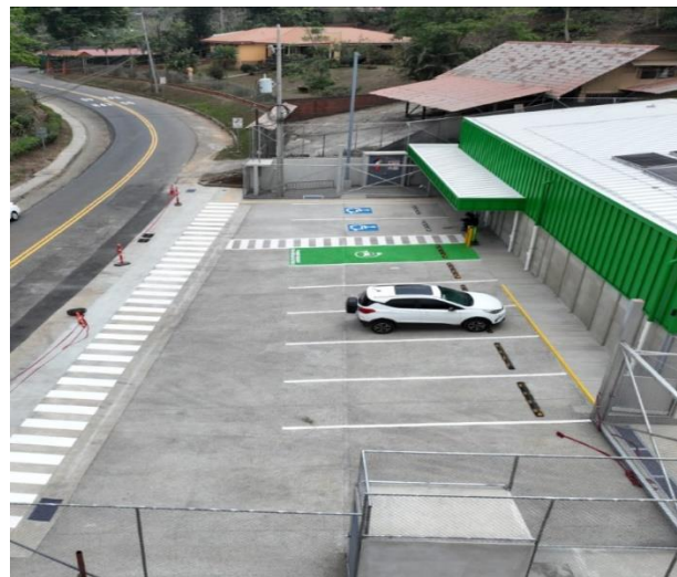
Parqueo en concreto permeable, Drenacreto Pali Candelaria para Dicoma
